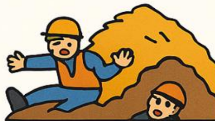
zasypání zbytkovou zemínou z ložné plochy nákladního automohilu
